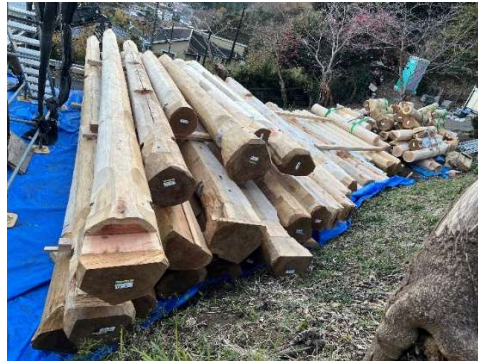
組み上げる前のログ
